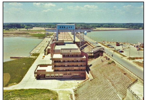
Donau-Wasserkraftwerk in Gabcikovo
